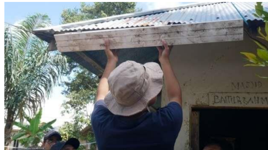
Gambar 4. Proses pemasangan system pemanenan air hujan
