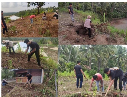
Gambar 1. Pembersihan taman pecatu, perataan tanah, penimbunan tanah bekas longsor.
