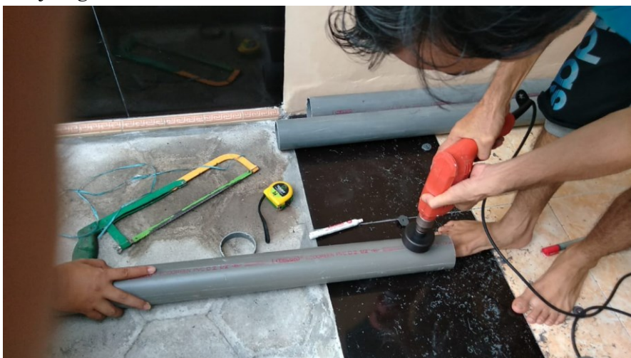
Gambar 5. Pelobangan Pipa.
