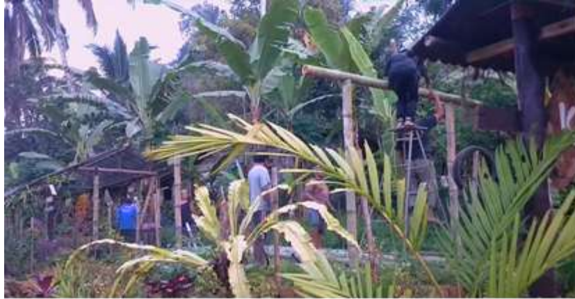
Gambar 1. Pembangunan fasilitas pondok di area kampung cantik
