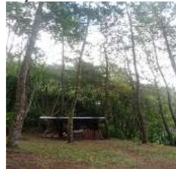
Gambar 2. Cafe Pinggir Kali sebelum proses renovasi
