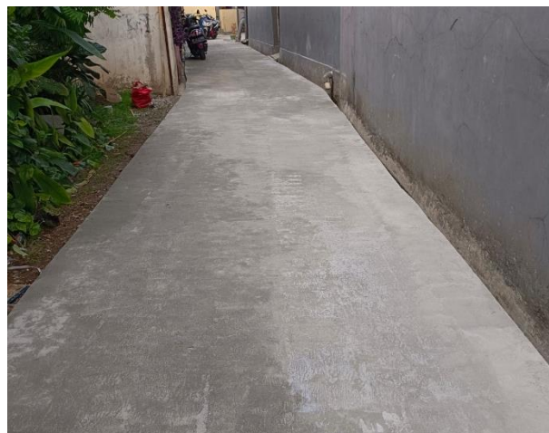
Gambar 4. Kondisi jalan setelah pengecoran
