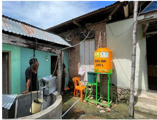
Gambar 4. Pengecekan Kembali setelah dilakukan perawatan alat penjernih air
