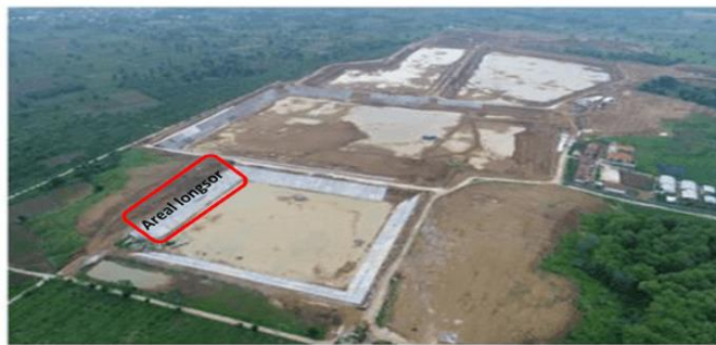
Gambar 2. Area kerusakan akibat longsor di Kolam Penenang.
