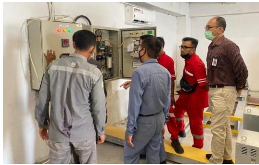
Gambar 2. Peninjauan lokasi panel kontrol panel surya
