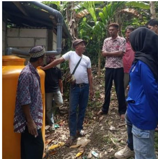
Gambar 3. Pendampingan Pemasangan Instalasi Pipa
