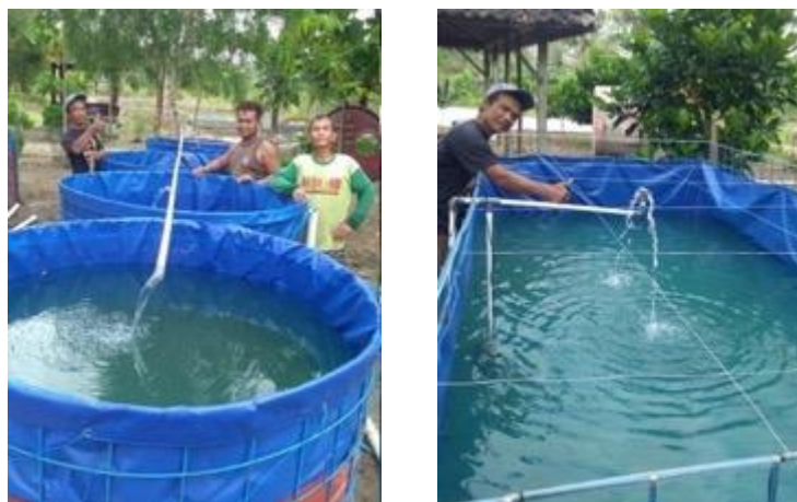
Gambar 4. Pemasangan instalasi pada kolam pemeliharaan ikan wader
