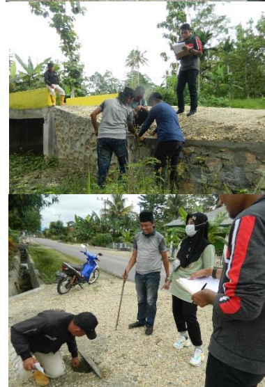
Gambar 11. Kegiatan pemantauan, pengawasan pelaksanaan pembangunan konstruksi
