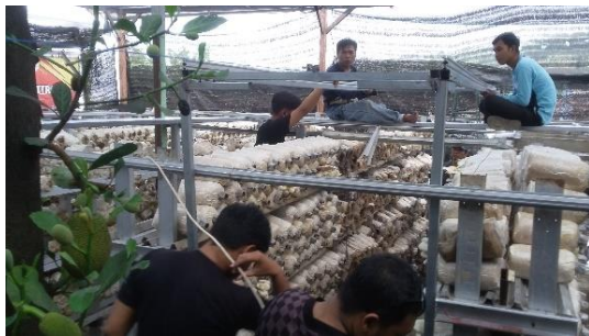
Gambar 7. Pemasangan Kerangka Penyiraman di Kumbung Mitra
