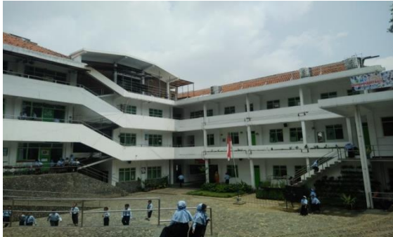
Gambar 1. Gedung SMK Muhammadiyah 1 Batu tampak dari depan
