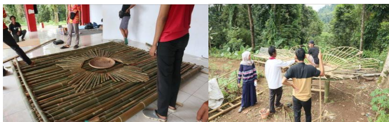
Gambar 6. Proses pelaksanaan konstruksi instalasi
