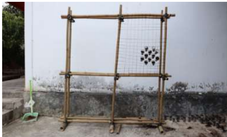
Gambar 3. Pemasangan kawat di modul green panel .
