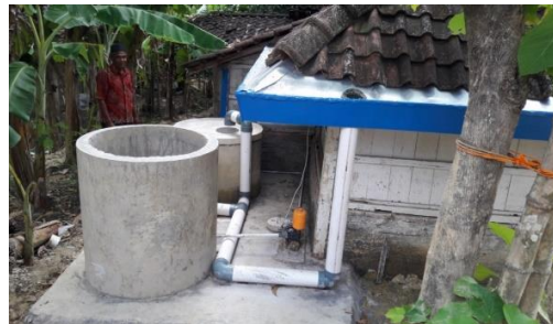
Gambar 2. Metode pemanenan air hujan ke sumur resapan.
