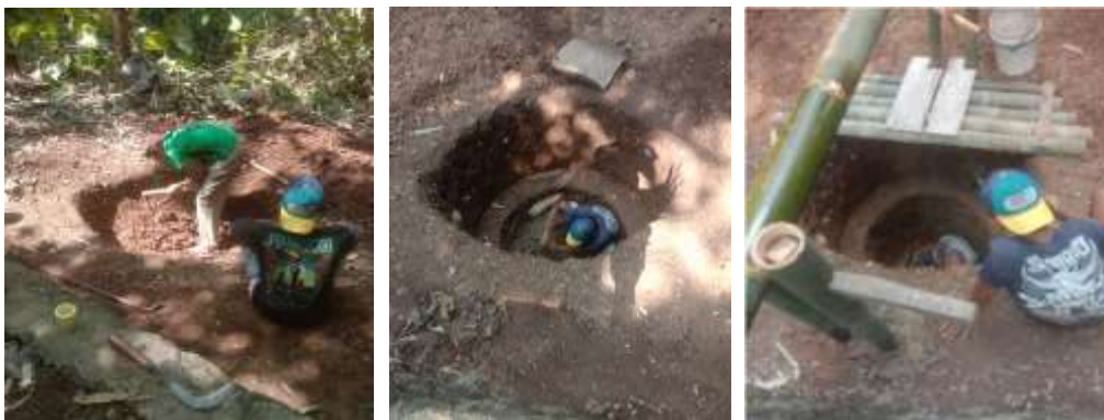
Gambar 4. Proses penggalian sumur gali di Dusun Jebreng.
