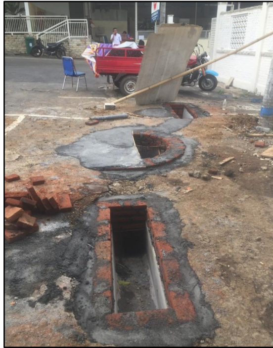
Gambar 5. Kondisi Sumur Resapan 2 Saat Pengecoran Tutup Sumur.
