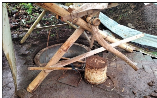
Gambar 4. Kondisi Sumur Resapan 3 Saat Konstruksi.
