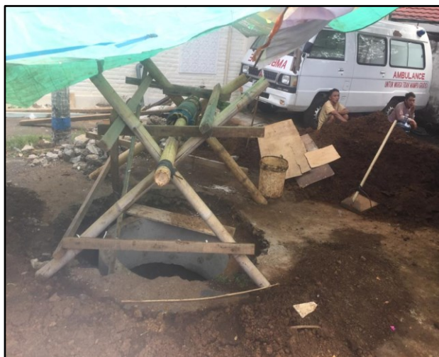
Gambar 3. Kondisi Sumur Resapan 2 Saat Konstruksi.
