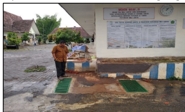
Gambar 6. Sumur Resapan 1 Pasca Konstruksi.
