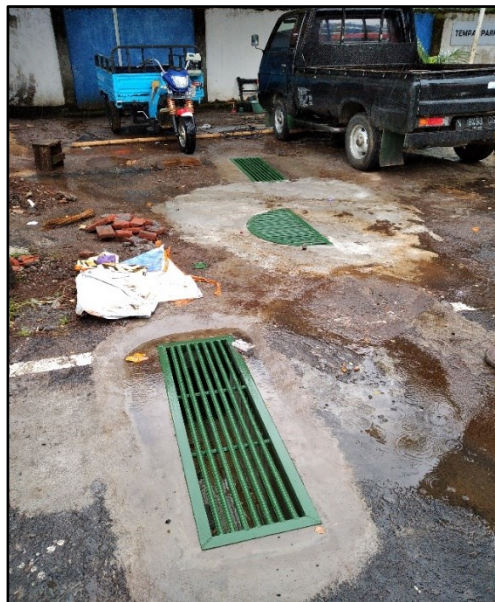
Gambar 7. Sumur Resapan 2 Pasca Konstruksi.
