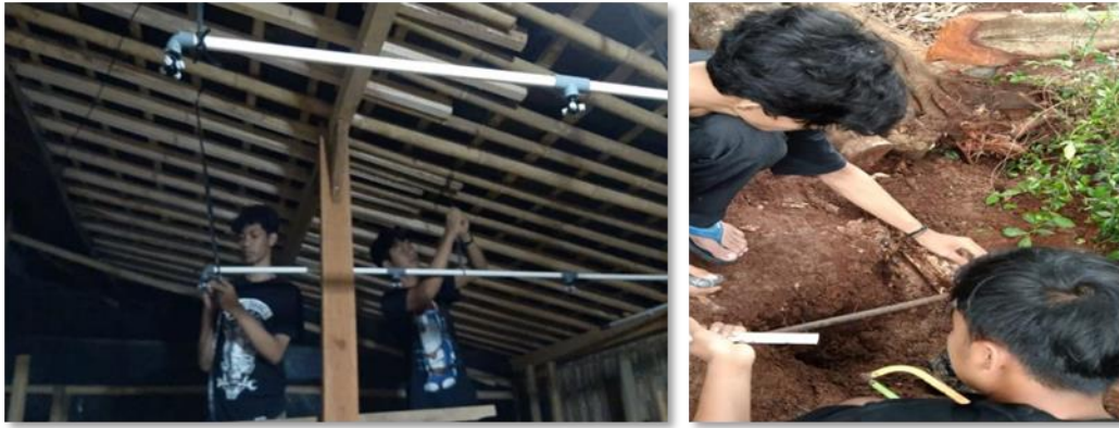
Gambar 4. Pemasangan teknologi penyiraman otomatis meliputi pemasangan pipa, penyambungan saluran air, pemasangan sprayer, dan uji coba alat
