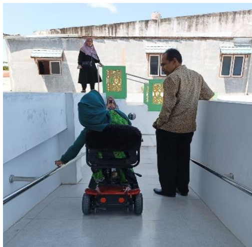
Gambar 5. Ketinggian posisi handrail pada sisi kiri dan kanan ramp tidak sesuai
