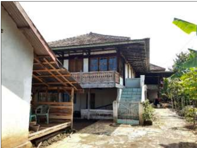
Gambar 7 Rumah Beton Hasil Pemugaran Rumah Panggung Sumber: Hasil Observasi (2020)
