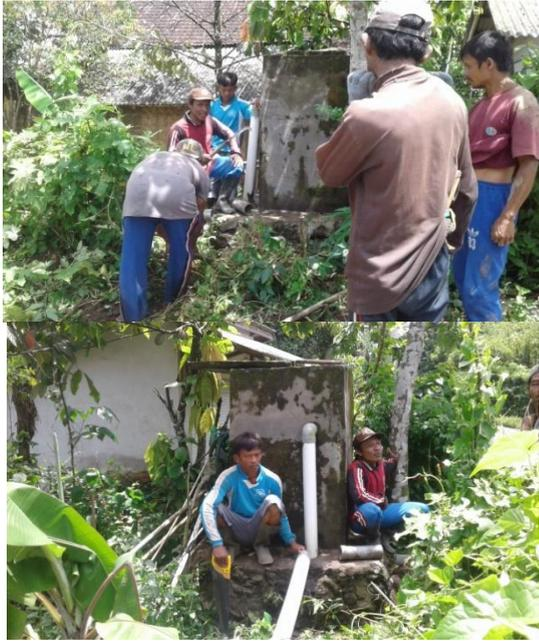
**Gambar 3.** Perbaikan pipa yang menuju ke tangki air
