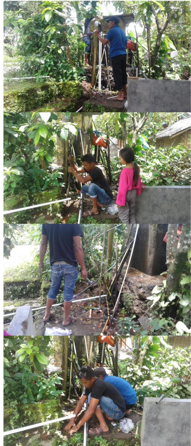
**Gambar 8.** Perbaikan pipa ½ inci di tangki air dan Penataan pipa yang terhubung ke tangki air
