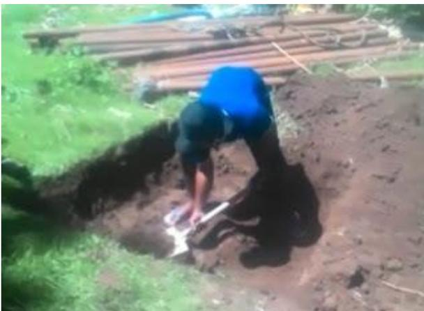
**Gambar 5.** Pembuatan Kolam Bor
