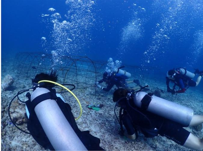
**Gambar 1.** Pemasangan Biorock
