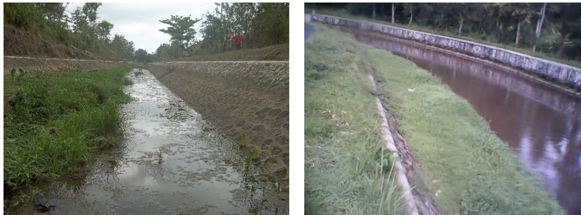
Gambar 1. Saluran irigasi primer tertutup sedimen
