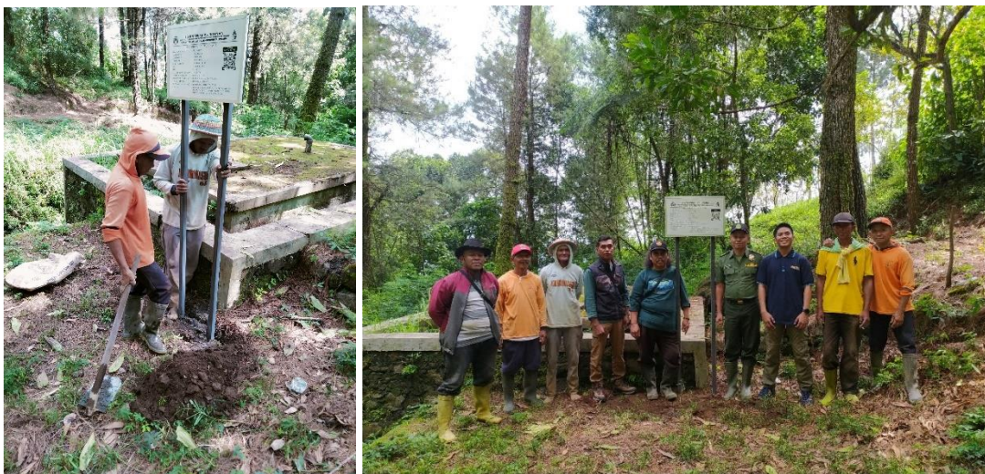
Gambar 3. Pemasangan Media Papan Informasi
