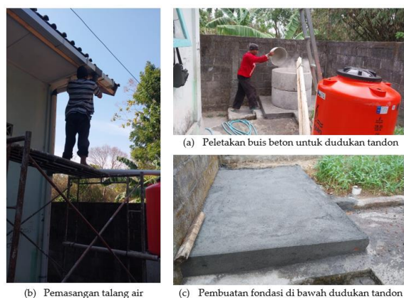
Gambar 6. Pemasangan alat pemanenan air hujan di belakang perpustakaan sekolah
