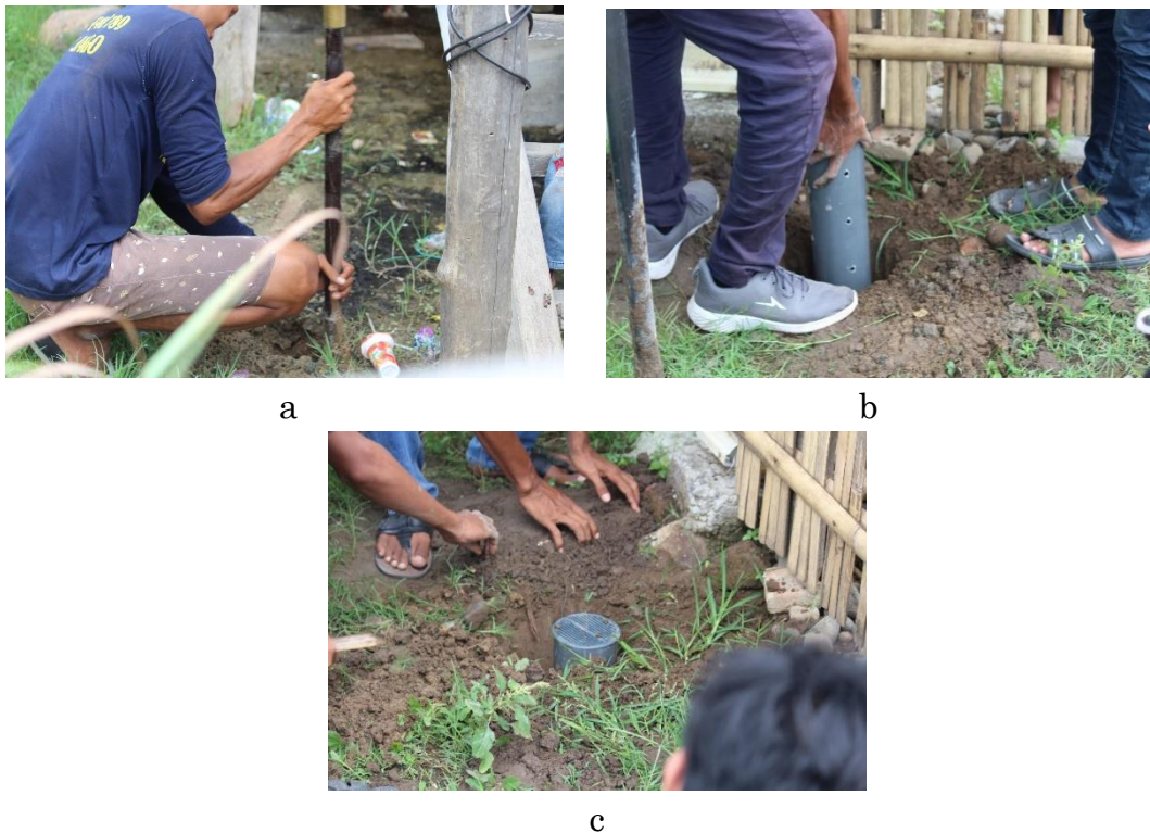
Gambar 3. (a) Proses pembuatan lubang; (b) Memasukkan pipa paralon ke dalam tanah yang telah dilubangi; dan (c) Menutup pipa paralon yang telah dimasukkan dengan tanah
