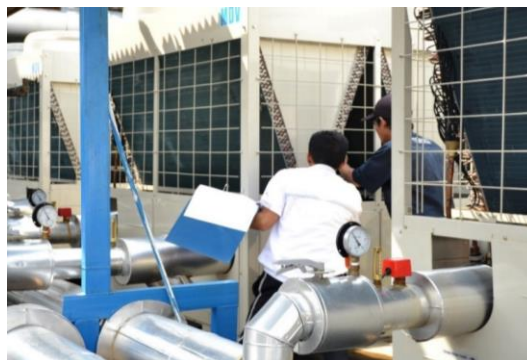
Gambar 2. Proses pendampingan pengukuran beban listrik
