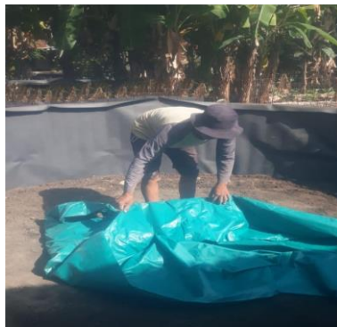
Gambar 3. Pemasangan Terpal untuk Persiapan Kolam Bioflok
