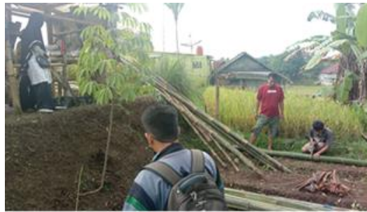
Gambar 4. Pembuatan Instalasi Shading House
