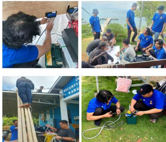
Gambar 5. Tim Dosen dan Mahasiswa melakukan pemasangan instalasi Panel Surya
