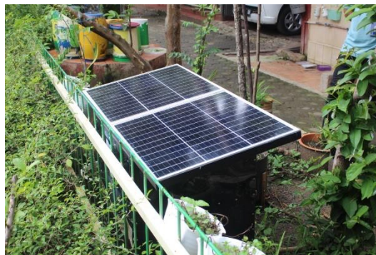
Gambar 2. Hasil Pemasangan Panel Surya yang Telah Terintegrasi
