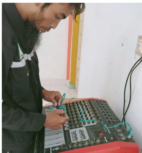
Gambar 3. Pemasangan Alat Pemutar Audio Pada Sistem Audio Masjid
