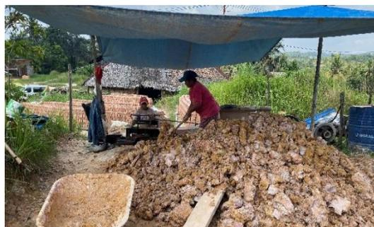
**Gambar 3.** *Unsafe Action* Pekerja Tanpa Menggunakan APD yang Baik
