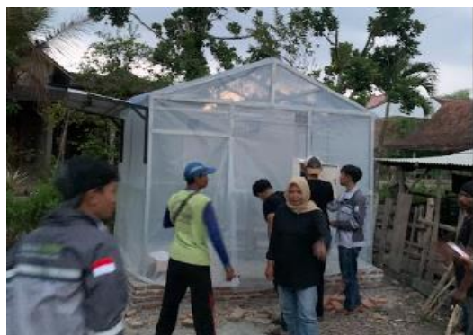
Gambar 4. Proses pembangunan rumah pengering surya.
