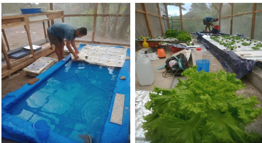
Gambar 4. Pemasangan instalasi hidroponik
