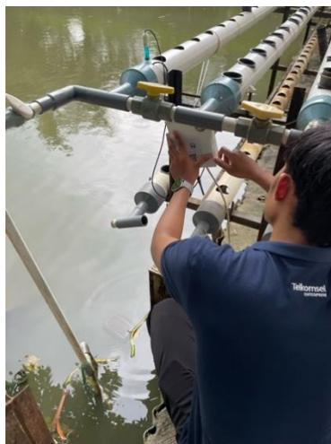
**Gambar 1.** Proses pemasangan sensor node sistem pemantauan akuaponik.
