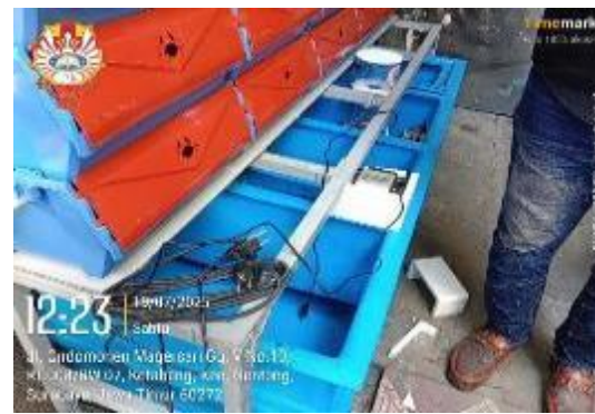
Gambar 3. Beberapa pompa yang telah selesai di pasang pada bak penampungan.
