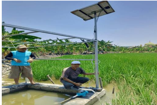
Gambar 4. Pemasangan Sistem Irigasi Tenaga Surya
