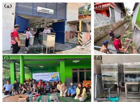
Gambar 5. (a) Rangkaian kegiatan program kemitraan masyarakat sistem penjernihan air irigasi Dusun Sanggrahan yang terdiri dari perakitan alat dan uji coba laboratorium; (b) instalasi alat di lokasi Dusun Sanggrahan; (c) sosialisasi, pelatihan, dan uji coba alat serta aplikasi filterku.com ; dan (d) alat penjernih air yang telah terpasang di Dusun Sanggrahan terintegrasi dengan IoT.
