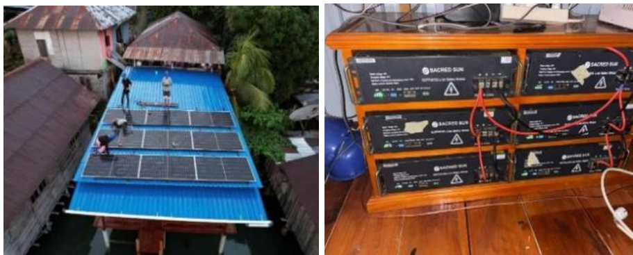
Gambar 2. Pemasangan seluruh komponen PLTS di rumah nelayan Tubudin.
