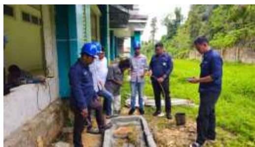
Gambar 2. Pengukuran Resistansi Tanah
