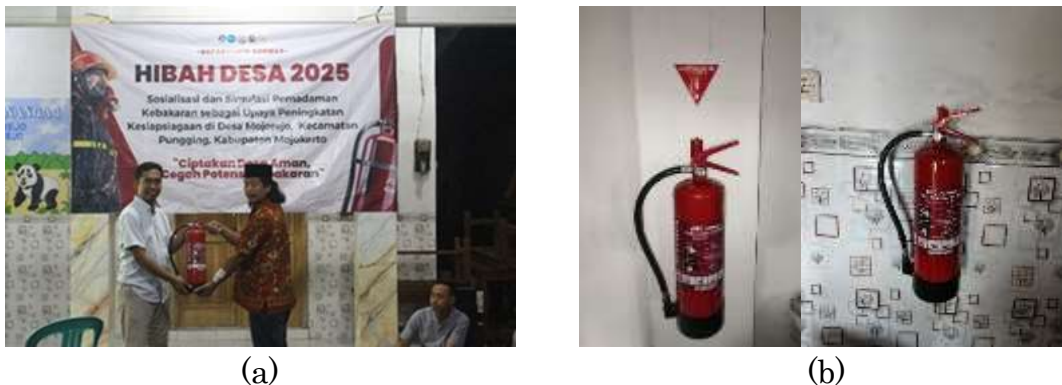
Gambar 2. (a) Serah Terima APAR kepada perwakilan warga dan (b) Pemasangan unit APAR sebagai fasilitas mitigasi bencana permanen di Dusun Mojorejo
