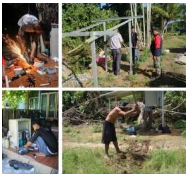
Gambar 4. Perakitan dan Pemasangan Sistem
