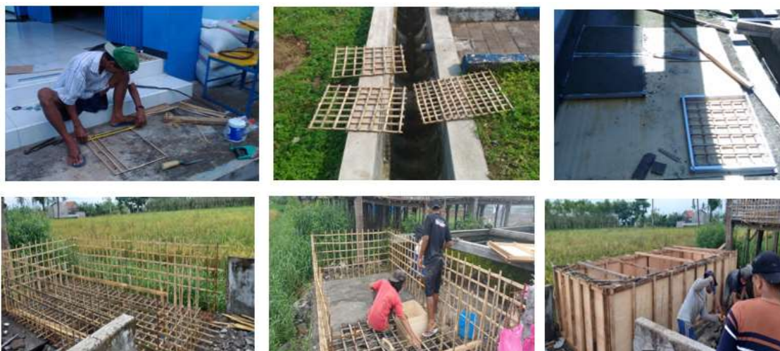
Gambar 2. Proses Pembuatan Pintu Irigasi dan Kolam dengan Menggunakan Rangka Bambu
