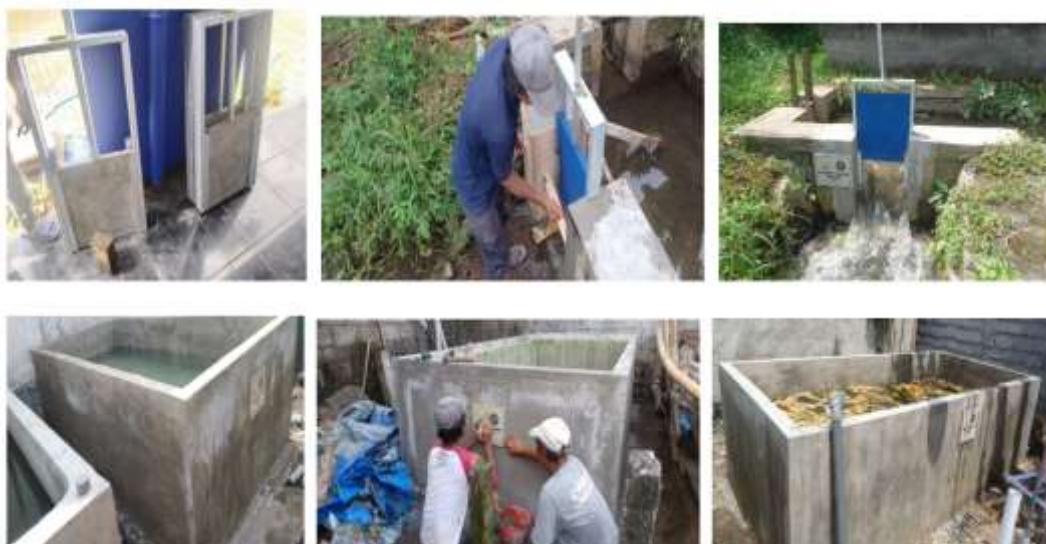
Gambar 3. Pintu air telah dipasang dan kolam ikan telah dibangun.
