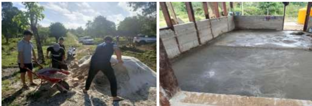
Gambar 3. Pembuatan Lantai Kerja Beton.
