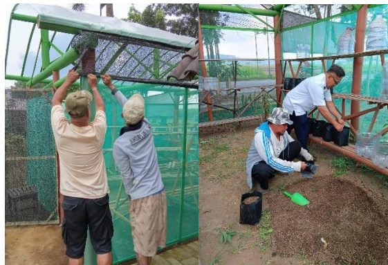
Gambar 1. Pembangunan dan Penataan Greenhouse
